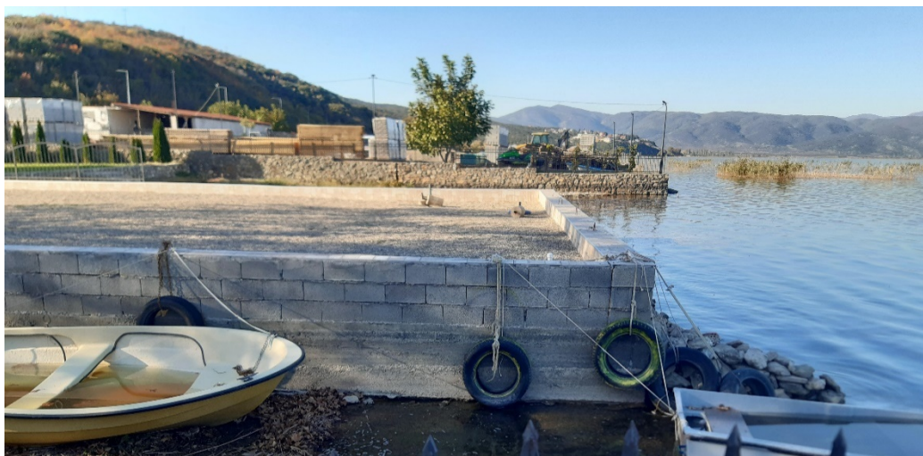
Слика 14: Бетонски и камени сидови на брегот.
